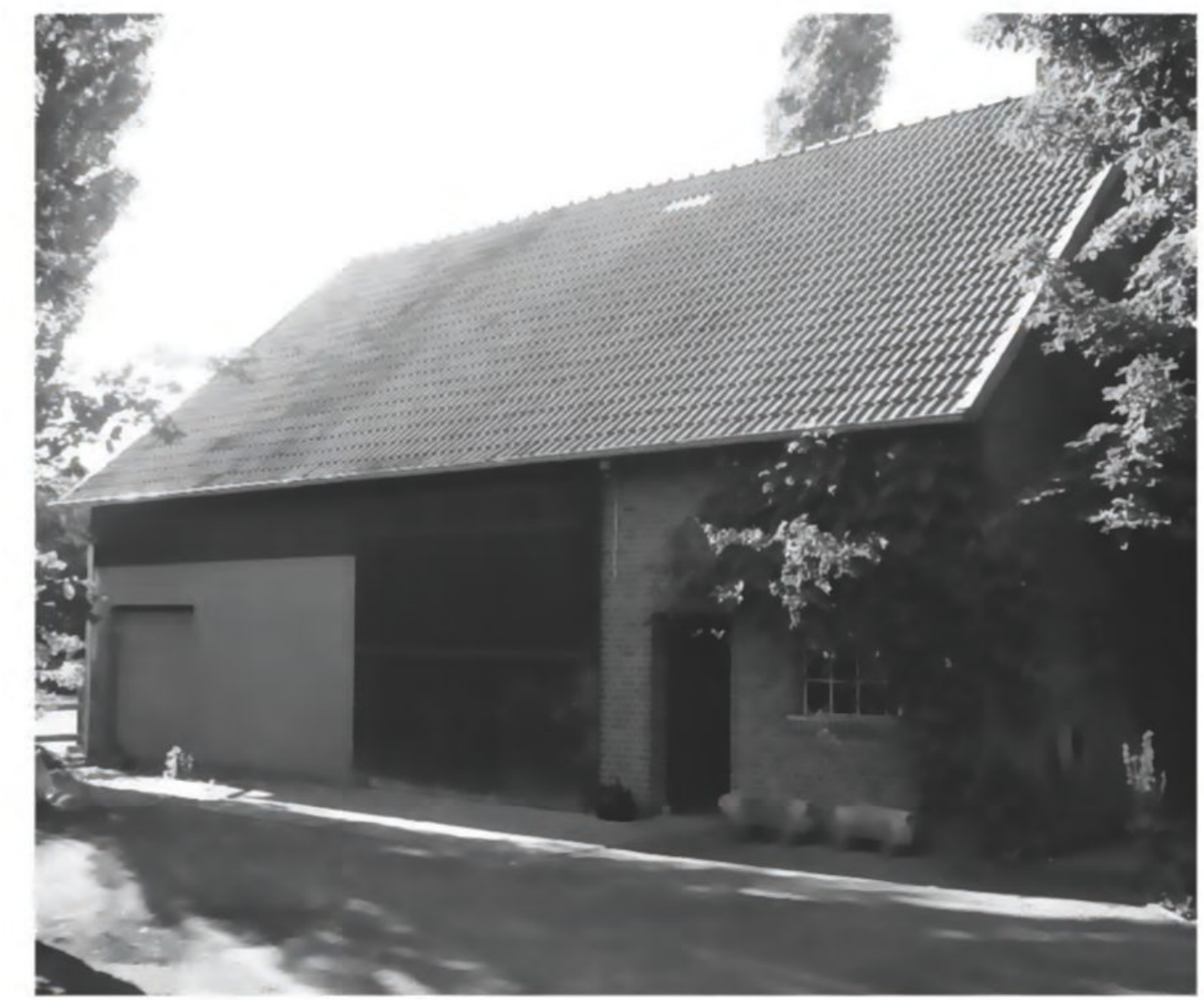
ERSCHEINUNGSBILD DER ALTEN SCHEUNE
