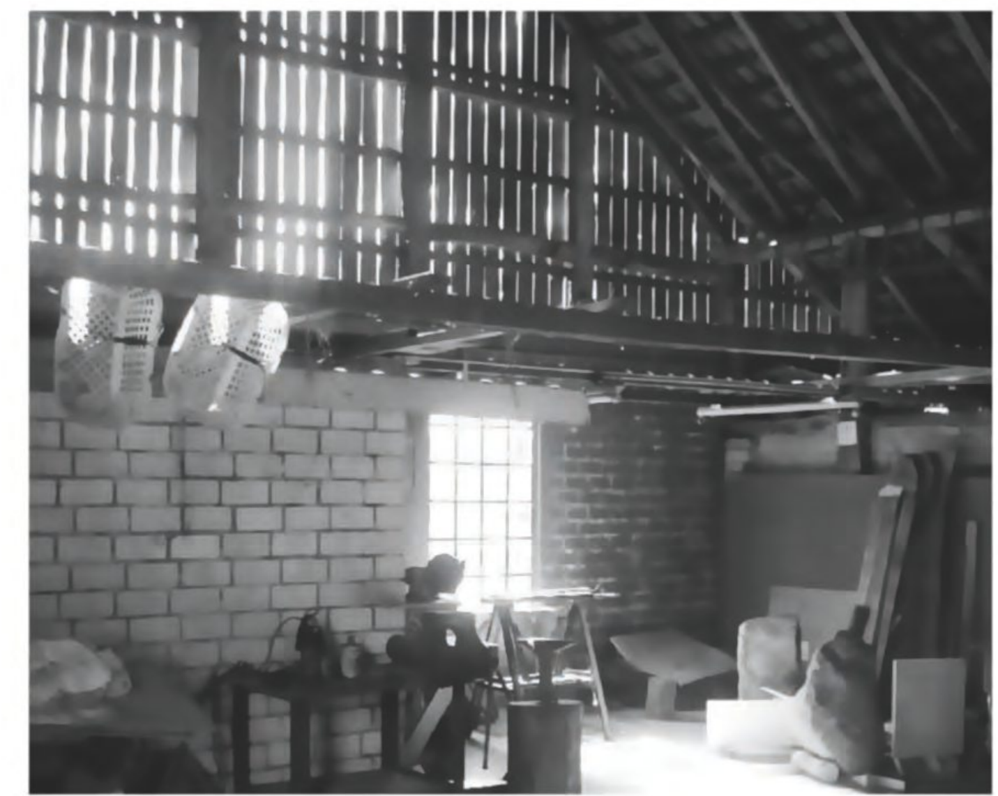
INNENRAUM VOR DEM EINBAU
